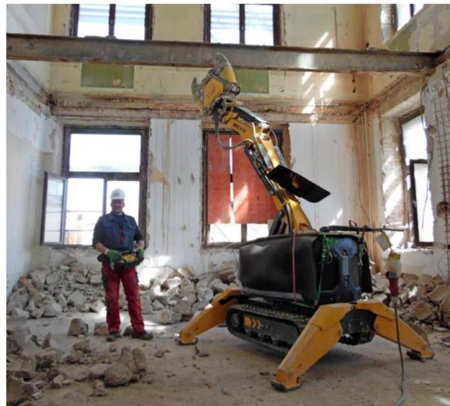
Bei Niemann und Heselschwerdt kommen moderne Maschinen wie beispielsweise dieser Abbruchroboter zum Einsatz.
