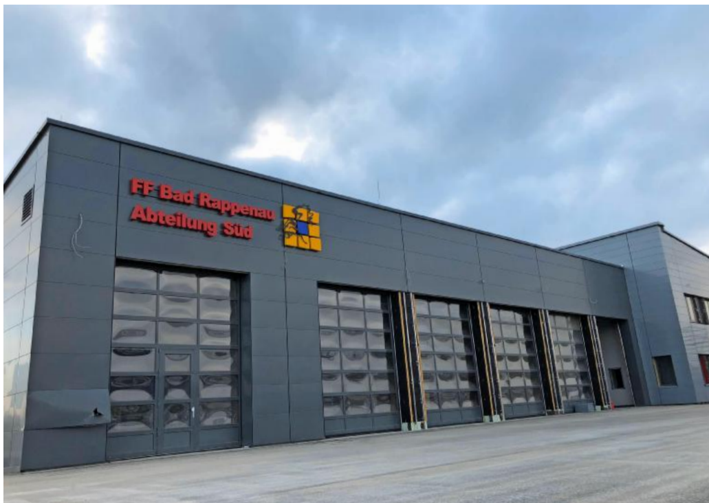
Das Unternehmen Niemann und Hesel-schwerdt setzt die unterschiedlichsten Bauprojekte in die Tat um – wie hier für die Feuerwehr Bad Rappenaau. Foto: privat
